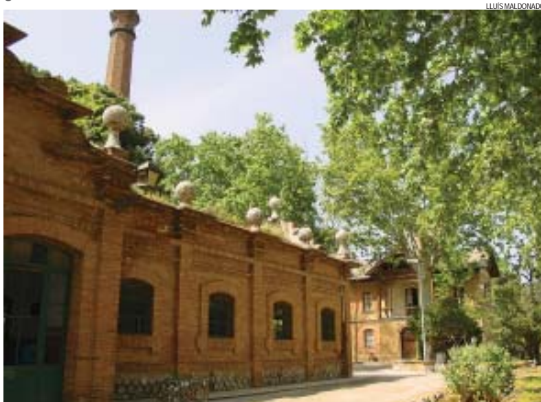
Vista exterior de la sala de màquines amb la Casa del Maquinista al fons. P. 4
